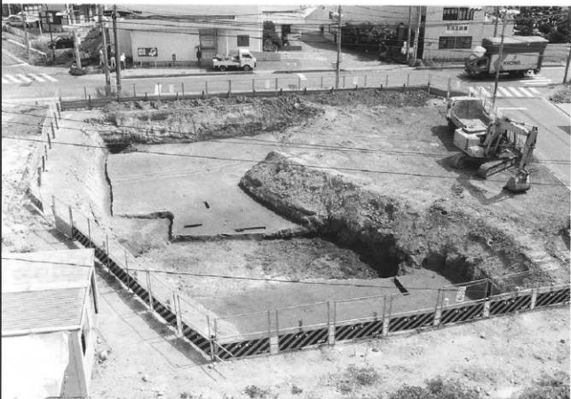
第1調査面全景 （南から）
