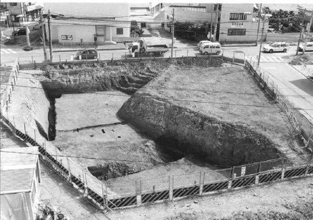
第2調査面全景 (南から)
