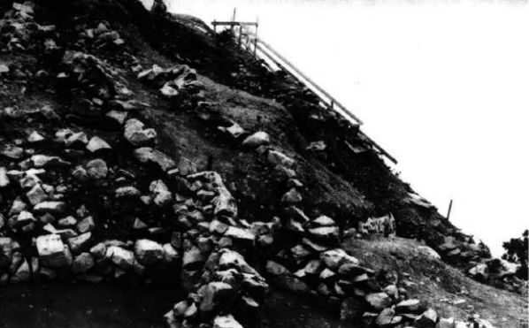
北東隅角の縦方向石積み (東北東から)
