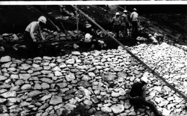
タコ・ランマーによって締め固められる葺石下地 (西側斜面北から)
