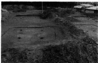
II調査区の遺構 - 西から
