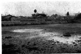
工事終了後の遺跡（南から）
