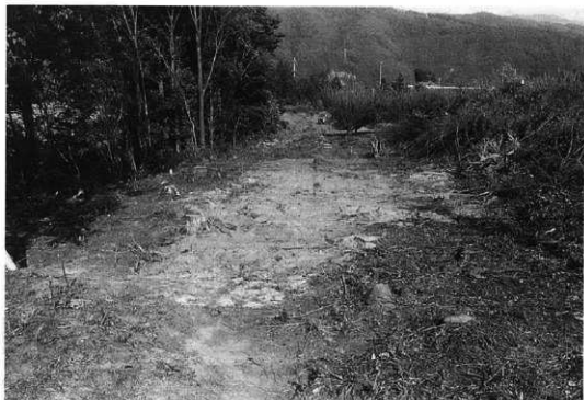
図6 調査地点全景
