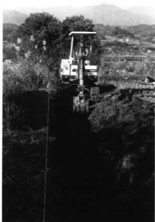
重機作業風景
