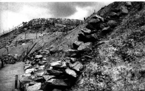
削り残された地山にそって 積まれた墳丘内石積み (南西より)
