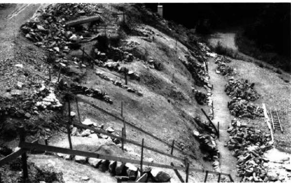
1次・2次石積みがそれぞれ 2～3段残っている (北より)
