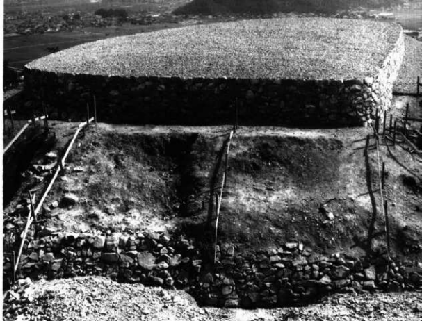
後円部前面石垣 前方部頂盛土で埋っていた (南より)
