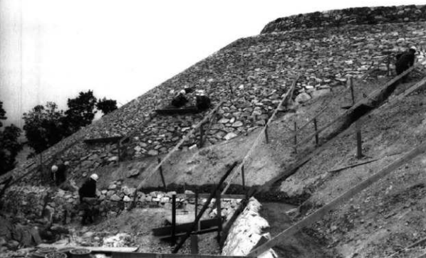
西側くびれ部 後門部墳丘施工後、前方形 施工 (南西より)
