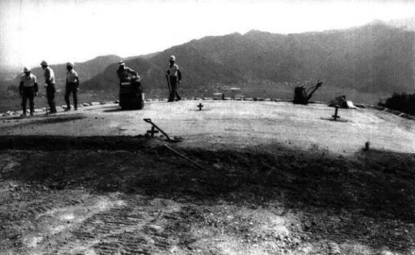
広い後門部墳頂 四和土敷設後玉砂利を敷く (南から)
