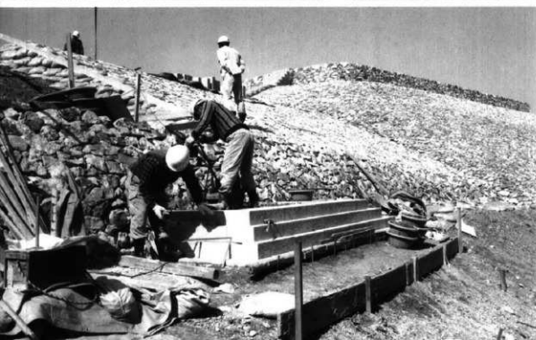
前方形東側 見学者用の階段設置 (南より)
