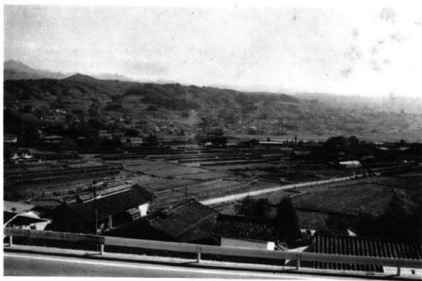
工事前の遺跡
