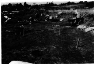
柱列址を掘る
