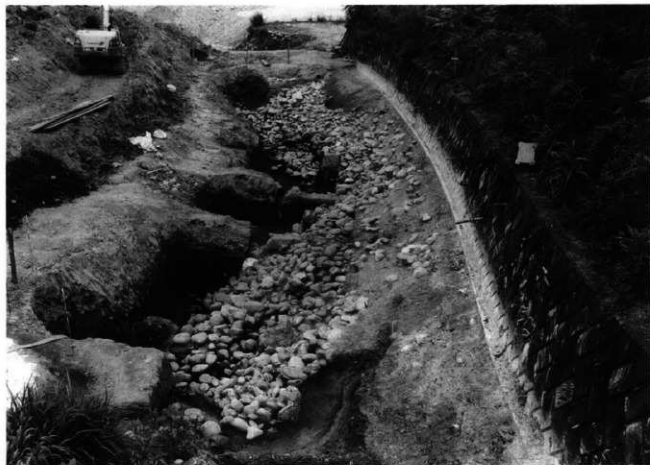
増丘北側葦石崩落状況（西から）
