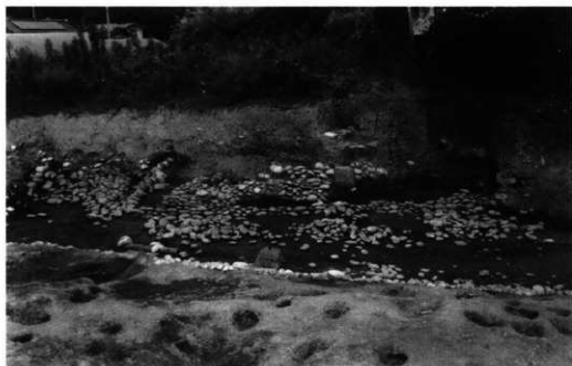
墳丘南側造り出し 崩落状況（南から）
