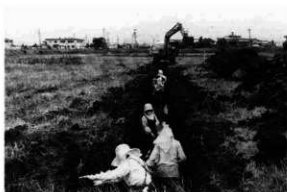
試掘坑の掘削作業
