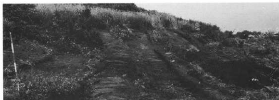
トレンチ掘削状況（西より）
