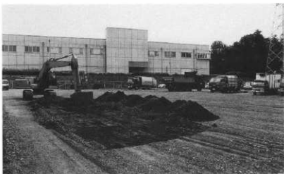
トレンチ掘削状況
