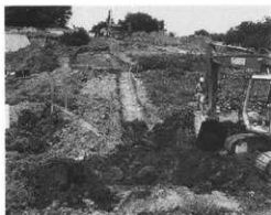
トレンチ掘削状況(東より)
