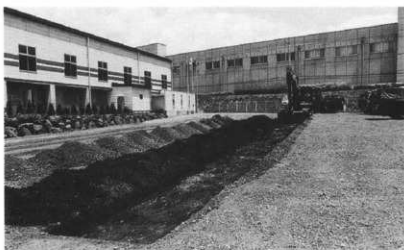
トレンチ掘削状況
