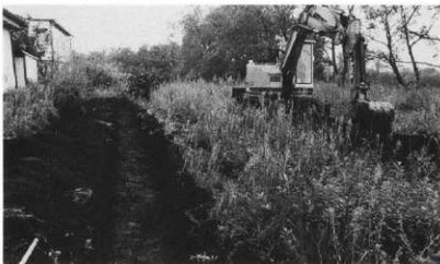
トレンチ掘削状況
