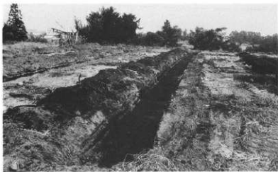
トレンチ掘削状況
