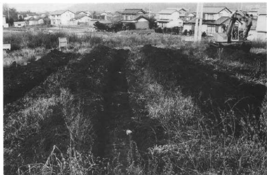
トレンチ掘削状況 (東より)
