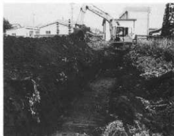
トレンチ掘削状況(西より)
