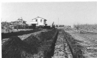
棧敷道跡トレンチ掘削状況
