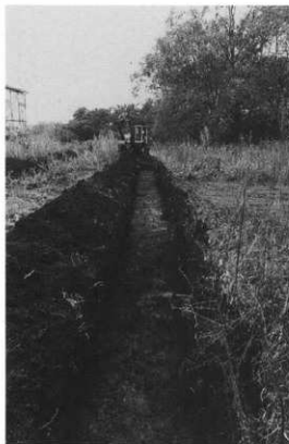
トレンチ掘削状況
