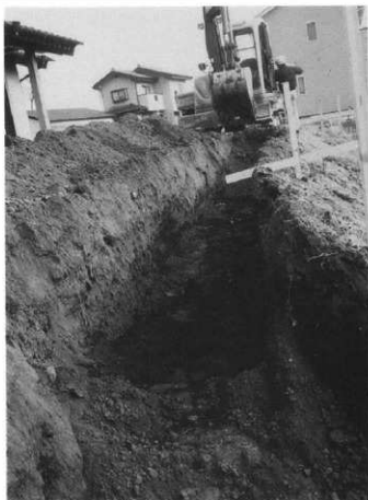
トレンチ掘削状況
