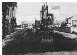
トレンチ掘削状況(東より)
