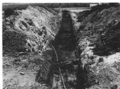
トレンチ掘削状況(北より)
