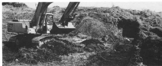
トレンチ掘削状況（西より）
