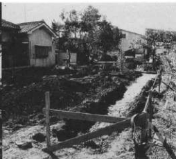
建物基礎部分近景(東より)
