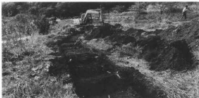
トレンチ掘削状況
