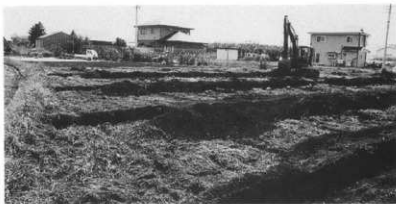
トレンチ掘削状況
