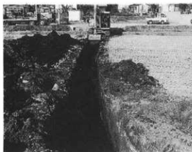
トレンチ掘前状況(南より)
