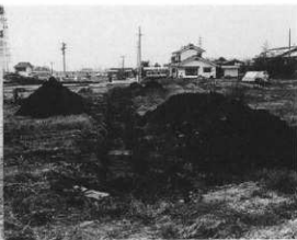
トレンチ掘削状況(東より)
