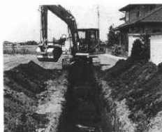
栗毛坂遺跡群調査状況
