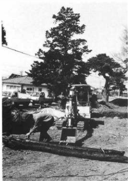
修羅引上状況
