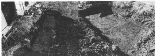
トレンチ掘削状況(西より)
