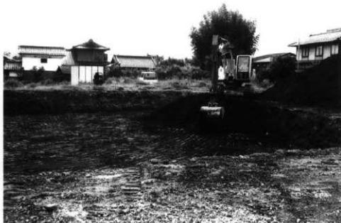
重機作業風景
