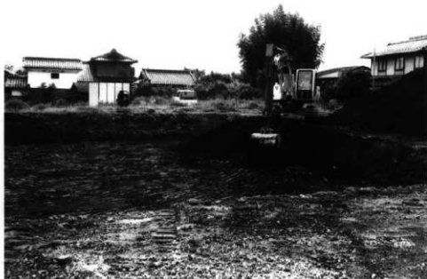
重機作業風景
