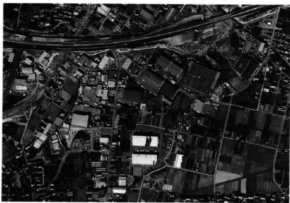
第5図 調査地付近遠景 (平成4年10月28日撮影)
