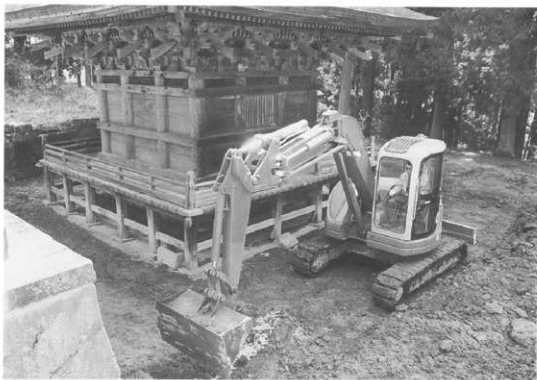
写真 21 三重塔周囲調査風景
