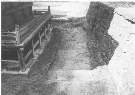
写真 22 三重塔北側トレンチ
