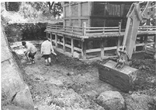
写真 19 三重塔北側調査風景
