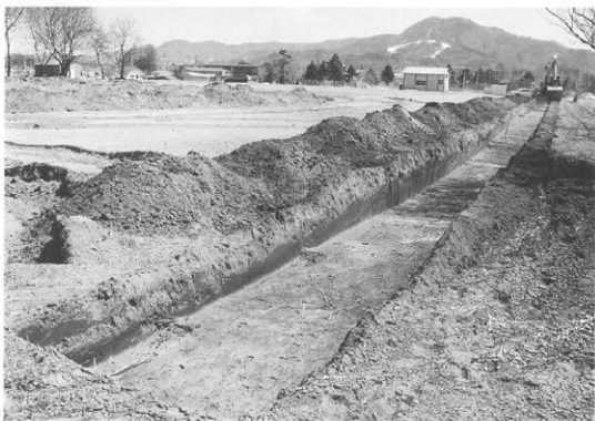
写真16 聖原Ⅱ遺跡トレンチ掘削状況
