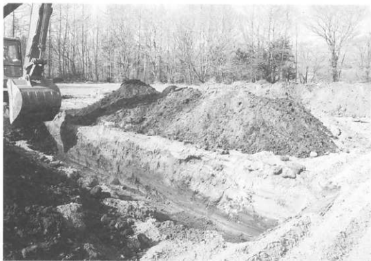
写真5 小田井城跡重機によるトレンチ掘削状況
