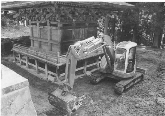
写真 21 三重塔周囲調査風景
