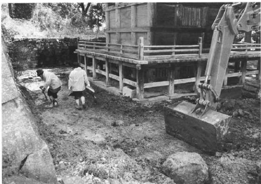
写真 19 三重塔北側調査風景
