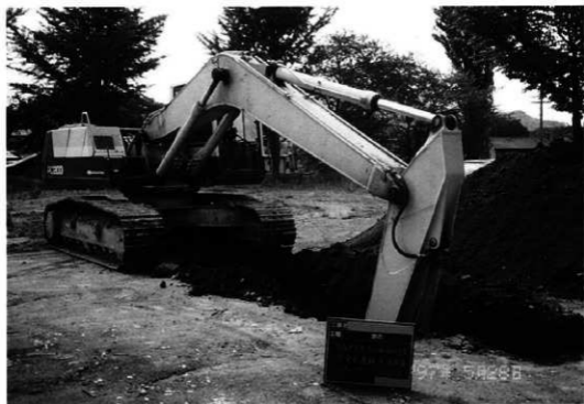
写真2 試掘坑1 掘削風景
