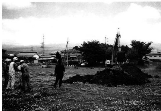
写真3 試掘坑2 掘削風景
