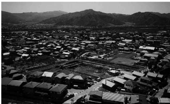
調査地遠景（北西から）
