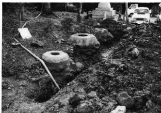
Aトレンチ完掘状況
