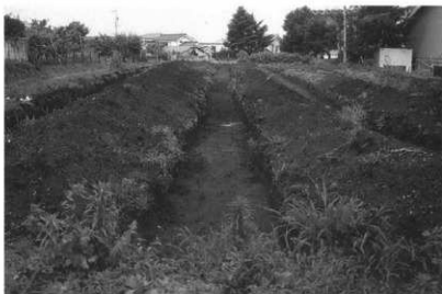
枇杷坂遺跡群 4 調査トレンチ
