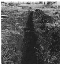
トレンチ掘削状況 (雨より)
