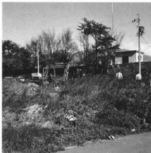
調査区遺景(南から)
