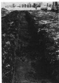
トレンチ掘削状況 (東より)
