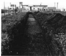
トレンチ掘削状況 (北東より) 試掘調査
