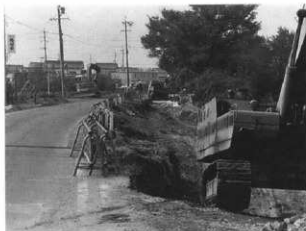
西大久保遺跡群3トレンチ掘削状況(東より)
