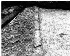
同上(粘土塊を除去した状態)
