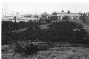
上の城遺跡群 3 トレンチ近景 (南方から)
