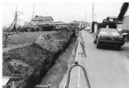
枇杷坂道跡群2 調査地点近景 (南方から)
