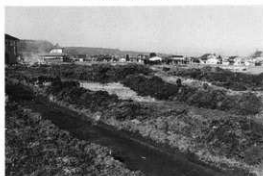
トレンチ近景 (東方から)
