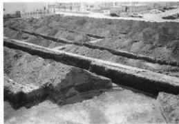
栗毛坂遺跡群12トレンチ近景 (北東から)
