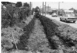
番屋前遺跡群 5 調査地点近景 (西方から)
