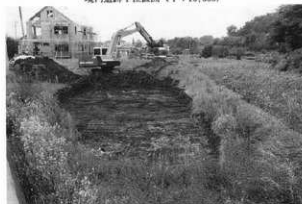
境内遺跡1 トレンチ定景 (東方から)
