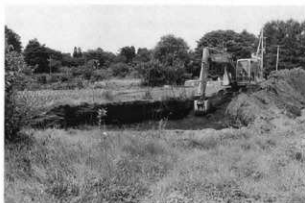
上の原遺跡群1トレンチ (北方から、重機の 後方に横根古墳群4号墳)
