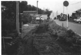
上小平遺跡1トレンチ近景 (西方から)
