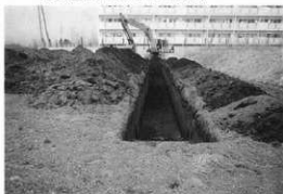
栗毛坂遺跡群4 B地区トレンチ近景(南方から)
