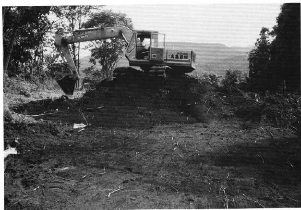
▲ 重機による表土はぎ
