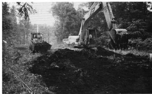
◀ 重機による表土除去
