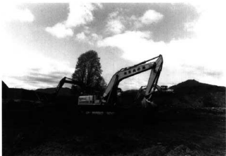
重機作業風景
