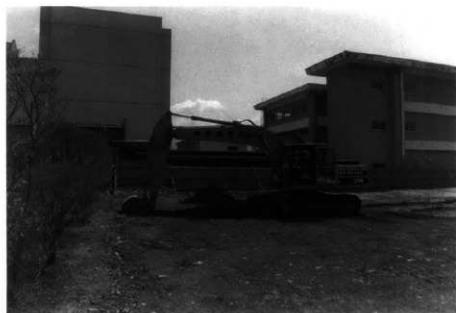
重機作業風景
