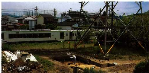
(発掘調査風景) 遺跡の北側を走るJR小海線、向かって左が小諾方面。
