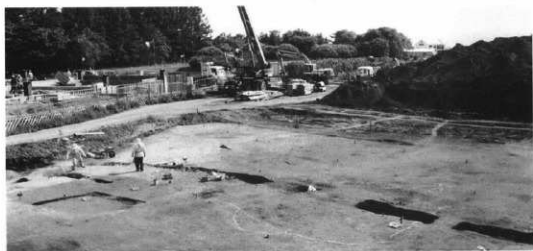
2 聖原遺跡X、B地区発掘調査風景 (東方より)
