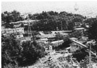
二本松遺跡隣接地 遠景
