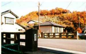
大川(歴代せぎ)にかかる大橋
