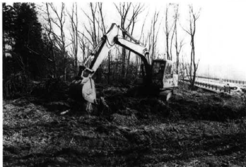
重機作業風景
