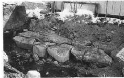
石の除去状況
