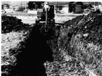
重機による トレンチ掘り (ZAPP21)
