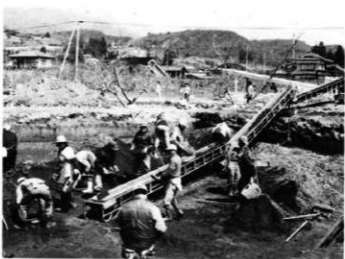
ベルコンを使用して の拵土作業 (確認調査)
