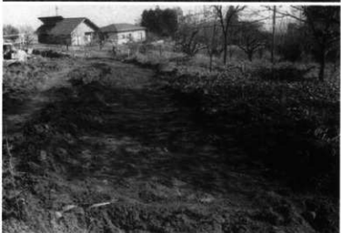
A区西より
