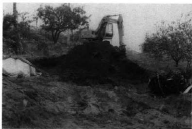
重機作業風景
