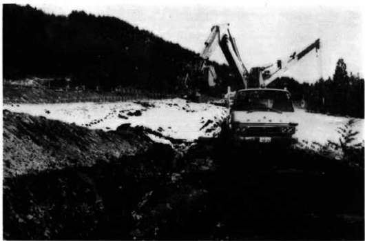
工事実施中の遺跡地
