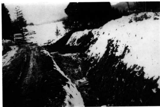
工事実施中の遺跡地
