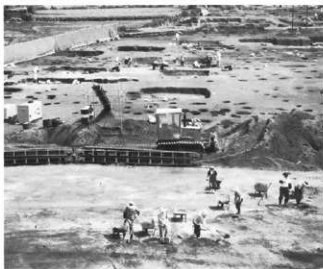
左 7号溝 作業風景
