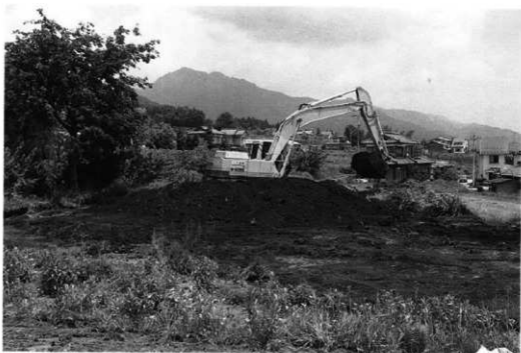
重機作業風景
