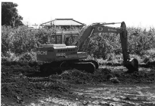
重機作業風景
