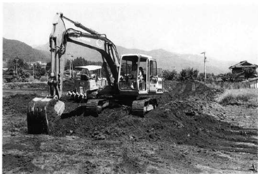
重機作業風景
