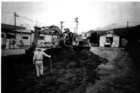
重機作業風景
