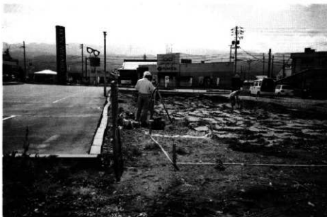
測量作業風景
