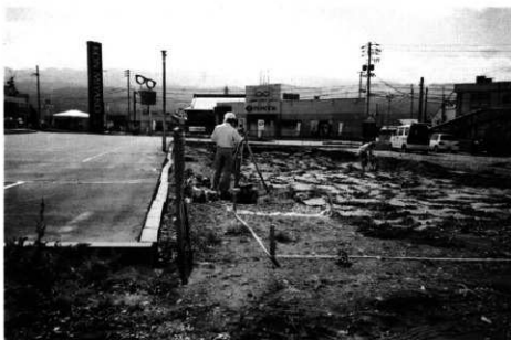
測量作業風景
