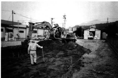
重機作業風景
