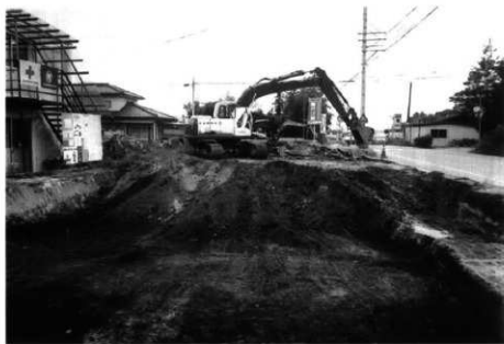
重機作業風景
