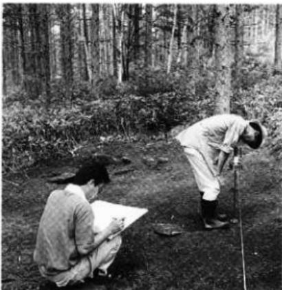
写真26 硬度計による調査
