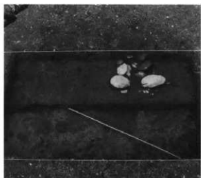
5 1-3区水道管埋設の状況
