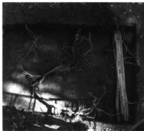
31 3-1区桜の根、電気ケーブルの状況
