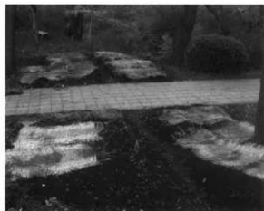
44 南曲輪埋め戻しの様子
