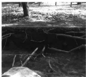
27 2-5区東壁土層断面と桜の根、水道管の状況
