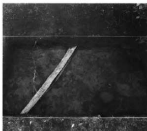
4 1-2区電気ケーブル埋設の状況
