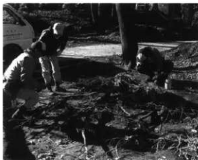
43 第3トレンチ埋め戻しの様子
