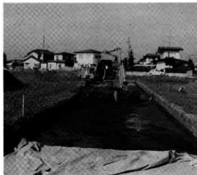
重機表土剥ぎ
