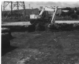
重機による表土剥ぎ状況
