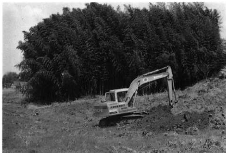
委託重機作業スナップ (b-cトレンチ)
