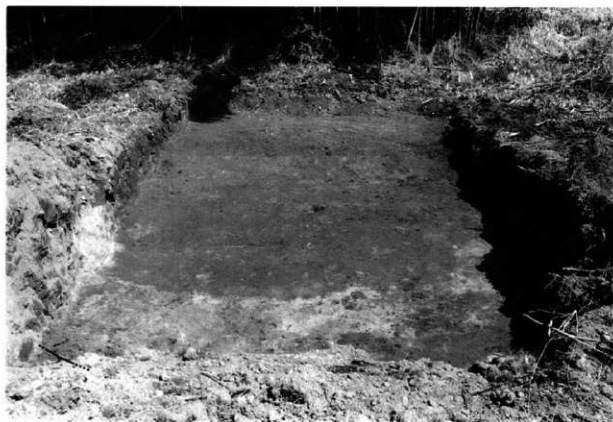
THAbトレンチ全景
