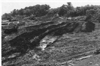
左 浅科トンネル坑口設計変更に伴う試掘調査
