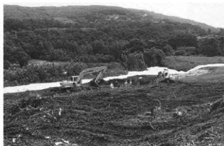
左 調査区内立木伐採状況
