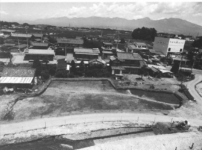
B・D区全景 (南から)
