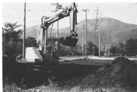
県遺跡A区表土はぎ
