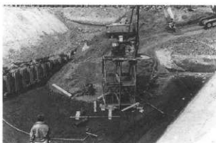
強制排水用井戸の掘削
