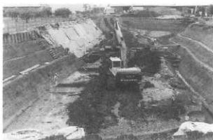
XV層 (縄文中期前葉) までの掘削 (⑤a区)
