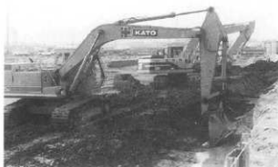
外周トレンチの掘削 (更塚柔里遺跡J地区)
