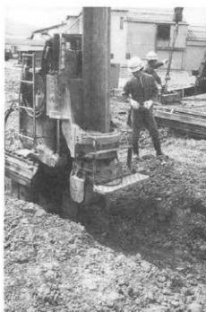
鉄道隣接区では振動を抑えるための機械を導入
