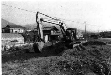
重機作業風景
