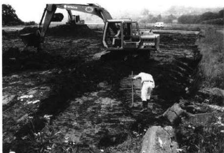
重機作業風景
